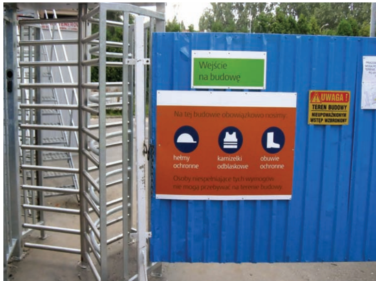
Fot. 10 Wejście na budowę.
