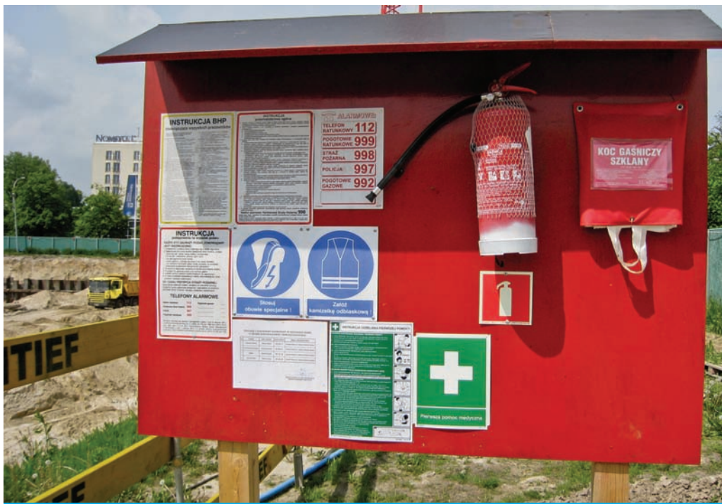
Fot. 55 Punkt ppoż na budowie.
