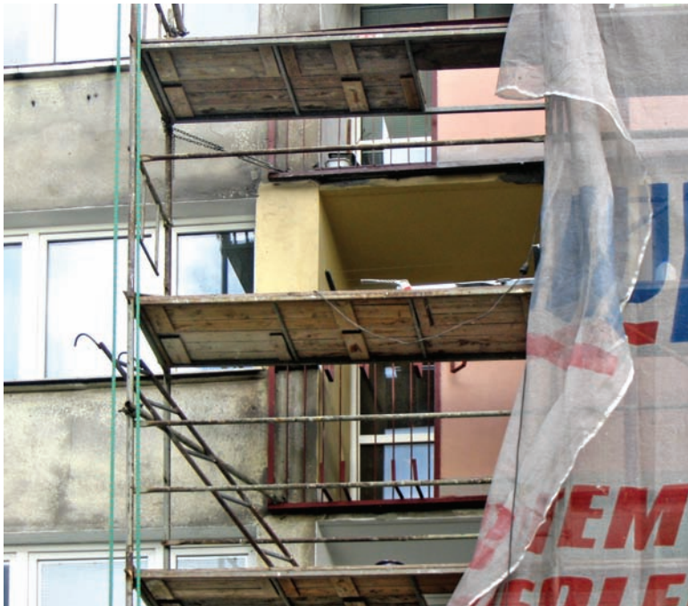
Fot. 2 Brak krawężnika i balustrady pośrodkowej. Pracownik nie powinien pracować na tym pomoście.
