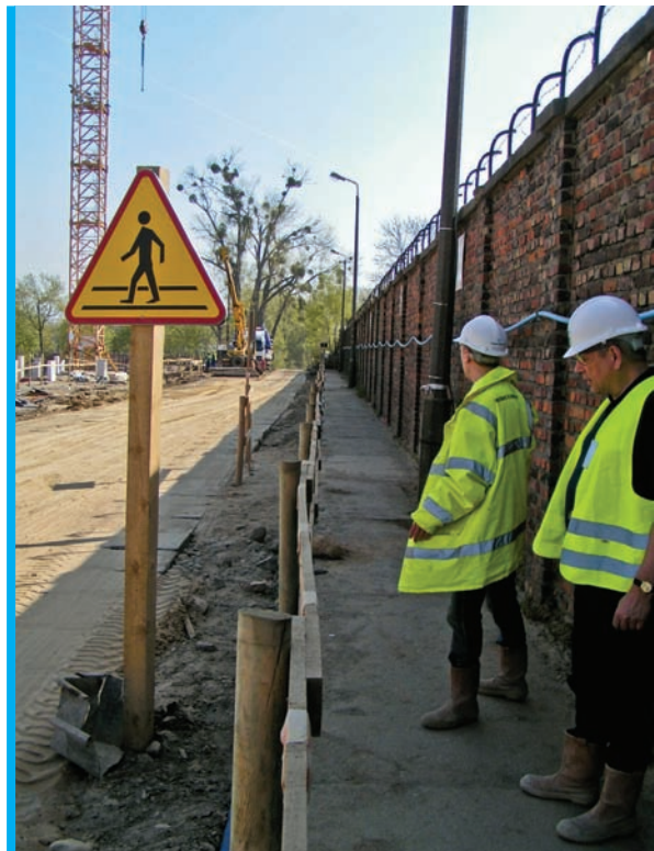
Fot. 12 Oddzielenie dróg dla pieszych od dróg dla ciężkiego sprzętu budowlanego.
