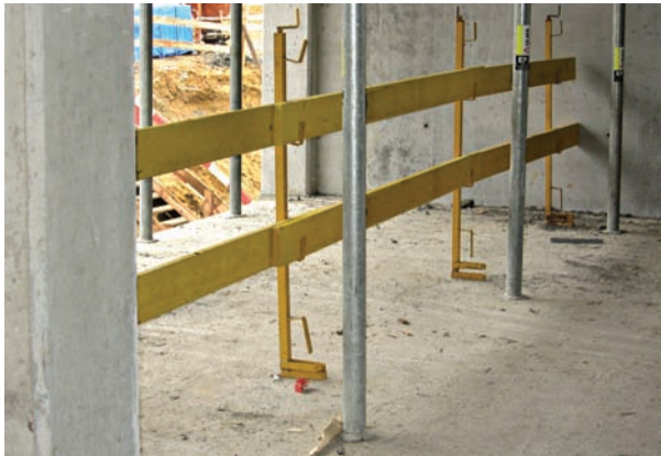
Fot. 28 Zabezpieczenie krawędzi otwartych stropów za pomocą balustrad mocowanych na specjalnych uchwytach.
