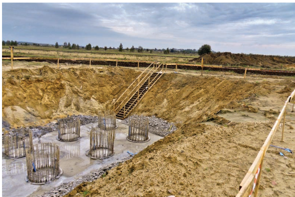
Fot. 34 Zejście do wykopu po schodach.
