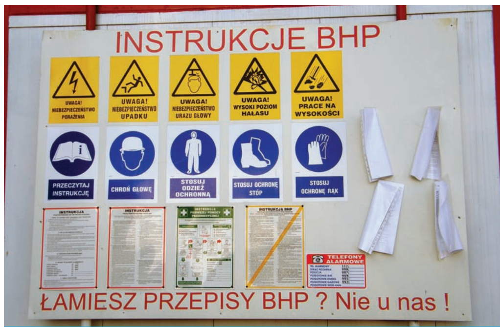
Fot. 11 Znaki bezpieczeństwa na tablicy informacyjnej lub na bramie budowy mają przestrzegać pracowników przed grożącym im niebezpieczeństwem na placu budowy.
