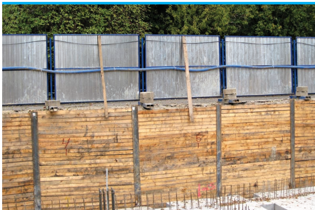
Fot. 31 i 32 Ściany pionowe zabezpieczone obudową.
