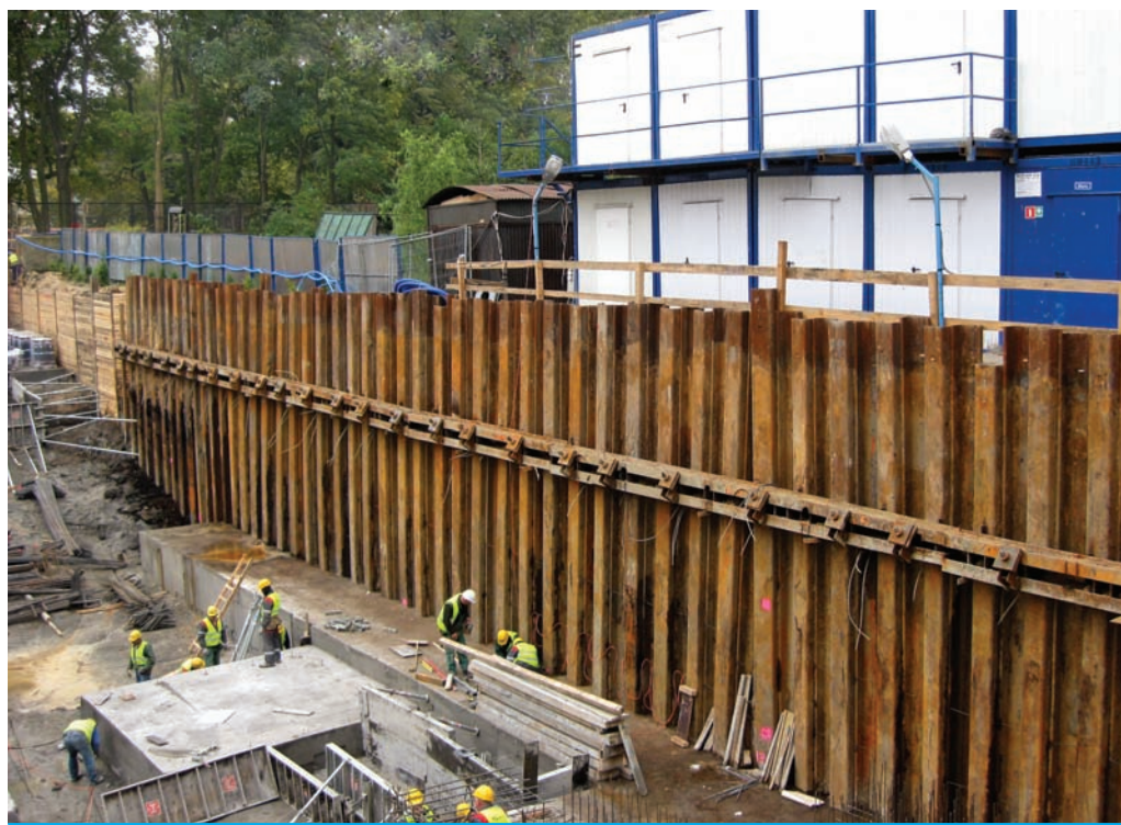
Fot. 31 i 32 Ściany pionowe zabezpieczone obudową.
