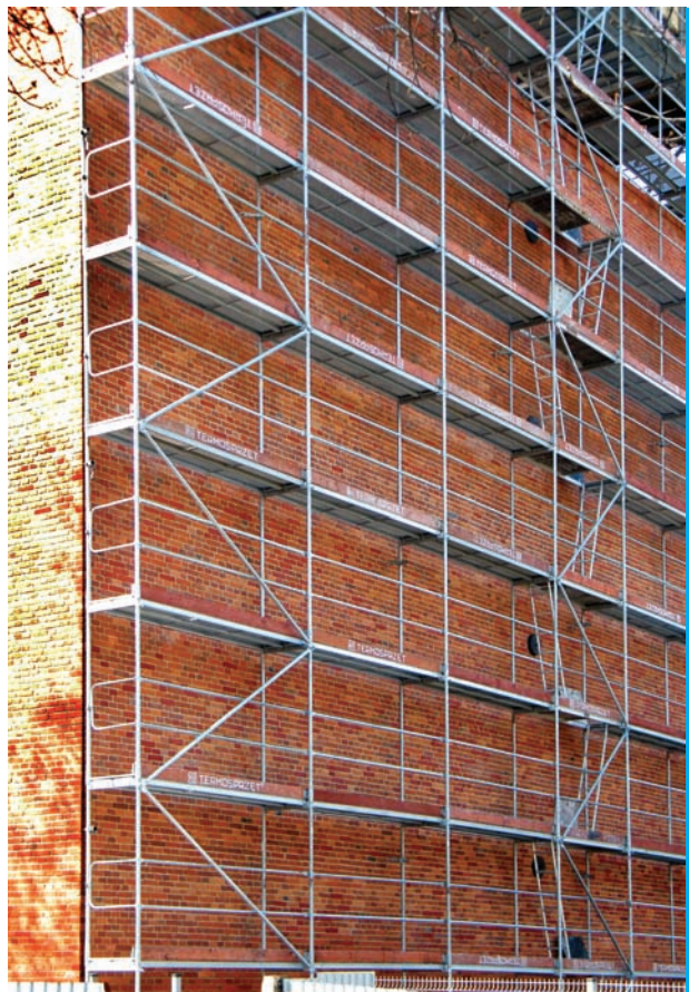
Fot. 19 Bezpieczny montaż rusztowania systemowego.
