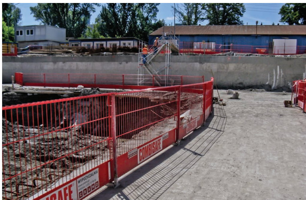
Fot. 35 Wygradzenie zabezpiecza osoby, które poruszają się w sąsiedztwie wykopu.
